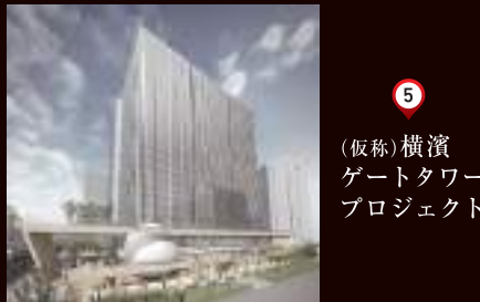
⑤ (仮称)横浜 ゲートタワー プロジェクト
