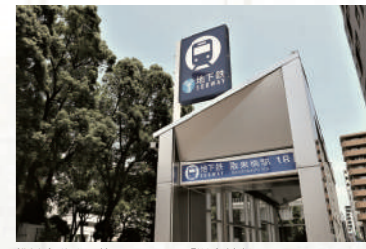
横浜市営地下鉄ブルーライン「阪東橋」駅
