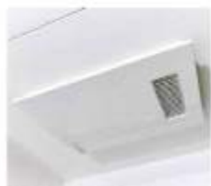
浴室換気乾燥暖房機 24時間換気や雨の日のお洗濯に最適な乾燥機能が装備されています。
